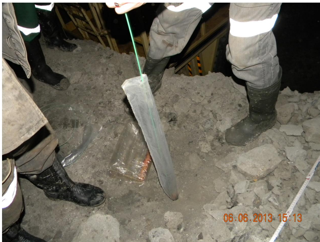
Рис. 6. Опускание заряда в шпур.
