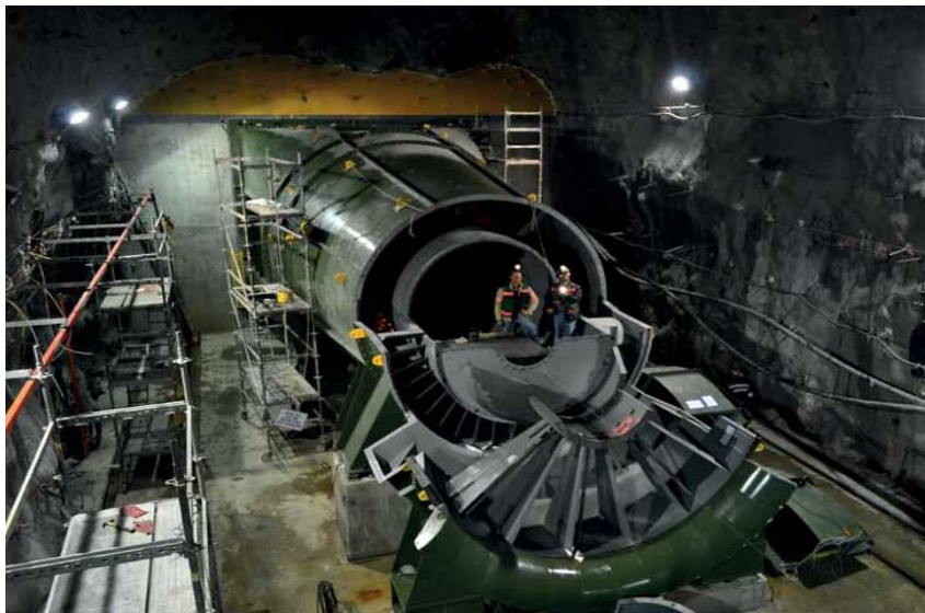
Рис. 1. Монтаж ПГВУ рудоуправление № 6 «Беларусь калий» РУП ПО
