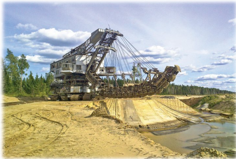
Рис. 1. Работа цепного экскаватора TAKRAF с нижним черпанием
