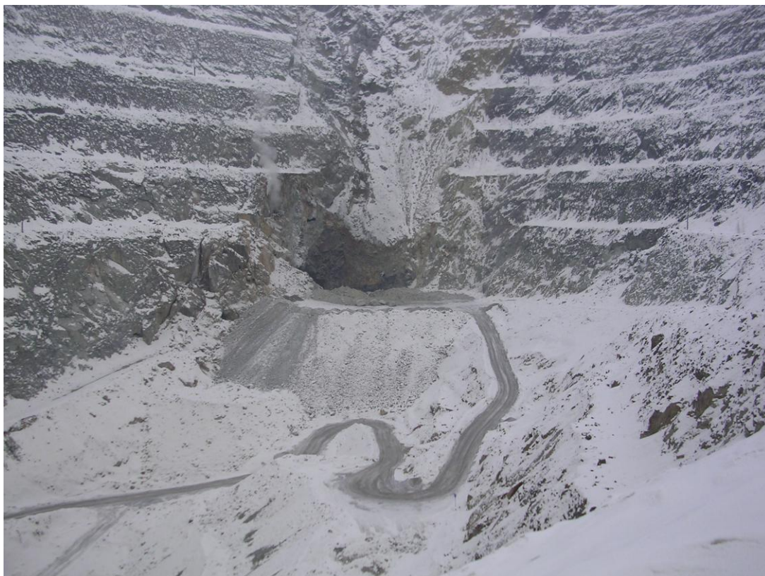
Рис. 11. Положение горных работ после окончания пригрузки борта.
