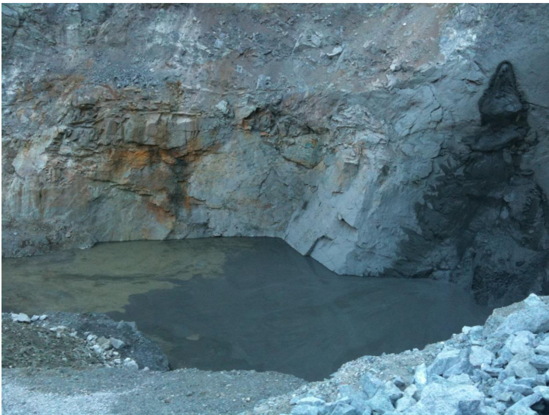
Рис. 6. Закладка выработанного пространства после выемки придонных запасов разделительного целика (камера К1ПЦС1-240).
