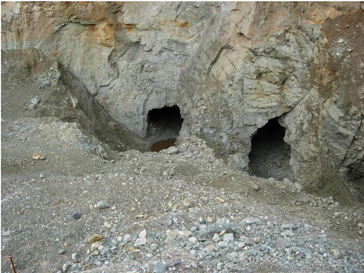
Рис. 4. Положение горных работ по окончании выемки придонных запасов разделительного целика (камера К1ПЦС1-240).
