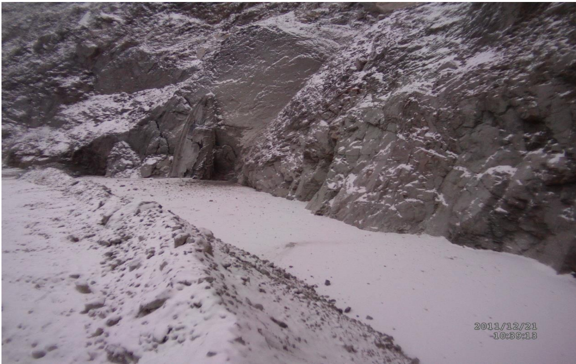
Рис. 11. Возведение комбинированного искусственного целика вдоль борта карьера (твердеющая закладка + скальная пригрузка).
