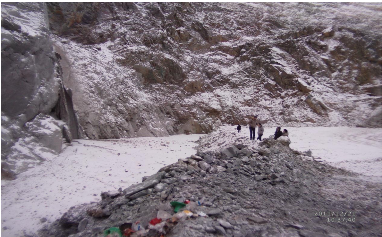
Рис. 10. Возведение комбинированного искусственного целика вдоль борта карьера (твердеющая закладка + скальная пригрузка).
