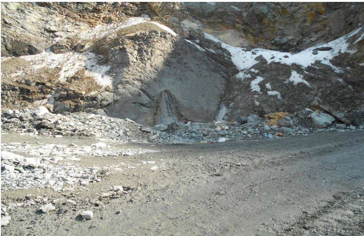
Рис. 12. Завершающая стадия возведения комбинированного искусственного целика вдоль борта карьера (закладочный массив возведён выше уровня кровли рудного тела).
